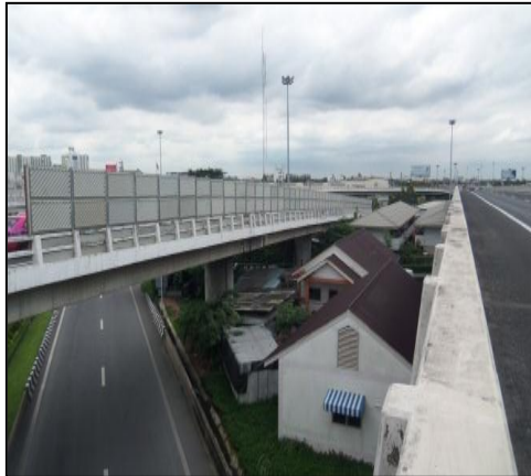
สภาพกำแพงชนิด FRP
