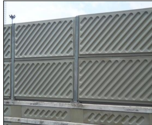
สภาพกำแพงชนิดFRP
