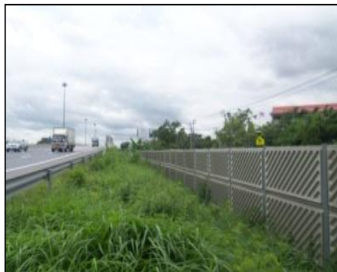
ช่องกำแพงที่ติดตั้งระดับพื้นถนน
