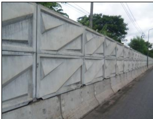
สภาพกำแพงชนิด GRC
