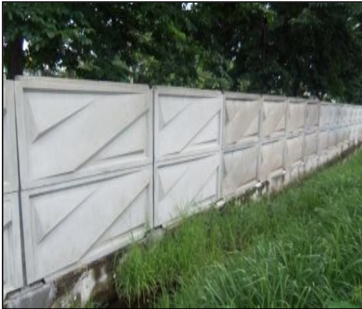
สภาพกำแพงชนิด GRC
