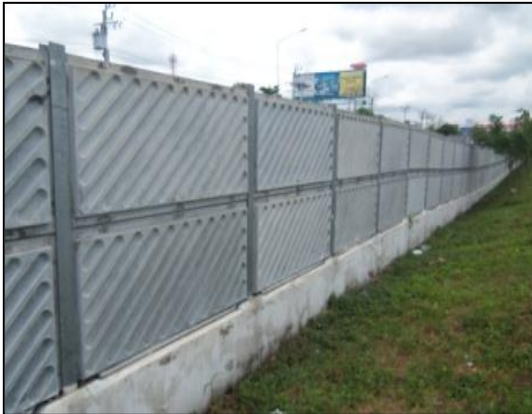
สภาพกำแพงชนิด FRP
