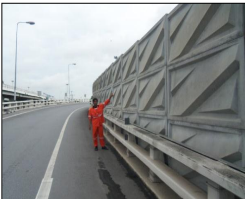
สภาพกำแพงชนิด GRC
