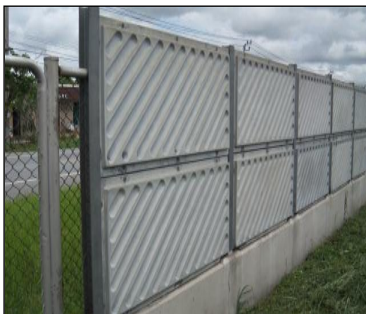
สภาพกำแพงชนิด FRP
