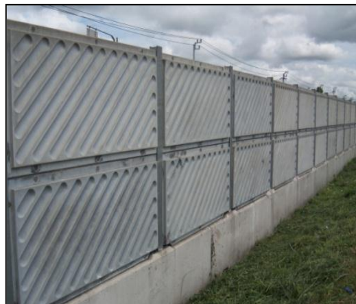
สภาพกำแพงชนิด FRP
