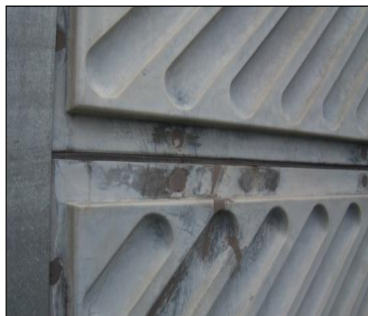
บริเวณจุดเชื่อมต่อระหว่างแผ่น กำแพงกันเสียง มีฟองน้ำ เพื่อปิดช่องว่าง
