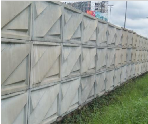
กำแพงกันเสียงชนิด GRC
