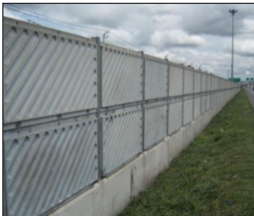
สภาพกำแพงชนิด FRP
