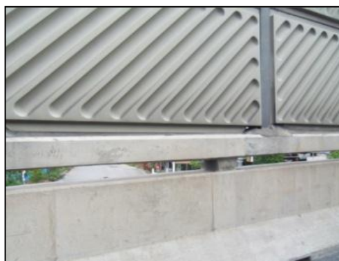
ช่องว่างใต้กำแพงจากการติดตั้ง
